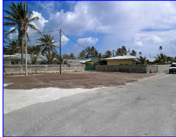
Zone AK43 après travaux
