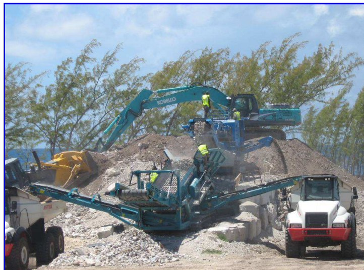
Zone de concassage des gravats
