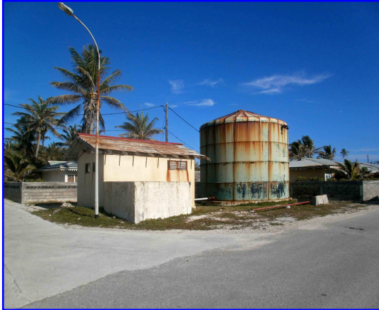
Zone AK43 avant travaux
